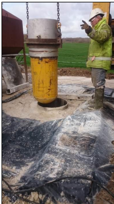
Photo 3 : Tube et sabot de cimentation
