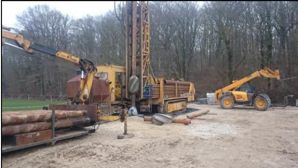
Photo 1 : Implantation de la foreuse
