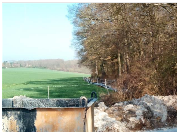
Photo 9 : Canalisations en place
